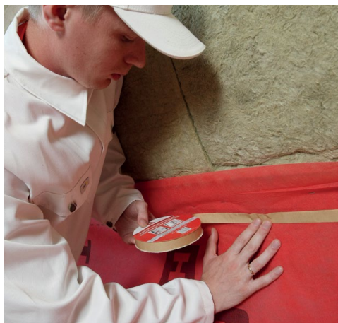
Рис. 6. Проклейка стыков пароизоляционной пленки
