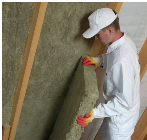
Рис. 3. Монтаж теплоизоляции враспор между стропилами
