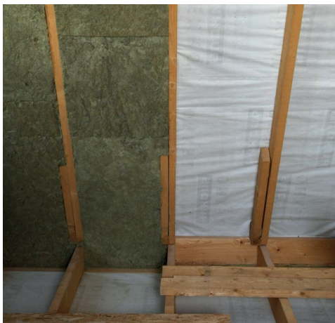
Рис. 2. Подготовленная система для дальнейшего монтажа теплоизоляции
