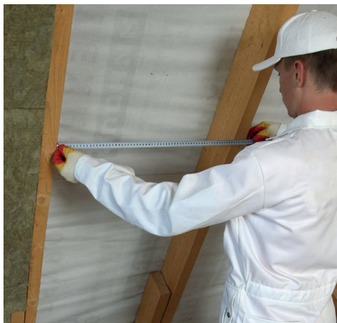
Рис. 2. Подготовленная система для дальнейшего монтажа теплоизоляции
