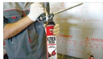
Для предотвращения образования мостиков холода более крупные зазоры между плитами необходимо плотно заполнить обрезками пенополистирола и **КЛЕЙ-ПЕНОЙ ТЕХНОНИКОЛЬ для пенополистирола**.
