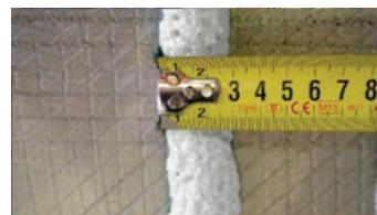
**КЛЕЙ-ПЕНУ ТЕХНОНИКОЛЬ для пенополистирола** следует наносить по периметру с отступом примерно 2 см от края плиты полосами шириной около 3 см и одной полосой через центр плиты на равном расстоянии от её длинных сторон. После нанесения КЛЕЙ-ПЕНЫ ТЕХНОНИКОЛЬ для пенополистирола на плиту необходимо выждать не менее 5 минут для полного расширения пены, и после этого зафиксировать плиту теплоизоляции на вертикальную поверхность.
