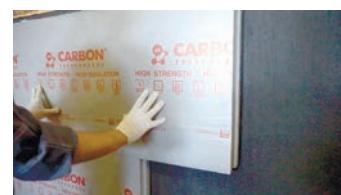
Приложить плиту с **КЛЕЙ-ПЕНОЙ ТЕХНОНИКОЛЬ для пенополистирола** к стене и слегка надавить. Зафиксировать плиту до момента схватывания клея. Плиты следует крепить плотную одна к другой с разбежкой швов. Зазор между плитами не должен привышать 2 мм. Регулировка панелей возможна в течение 5-20 мин. после их установки в зависимости от условий окружающей среды.
