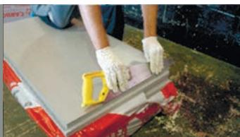
Перед началом монтажа плит из полистирола или XPS на поверхности следует укрепить стартовый фиксирующий профиль, на который будет опираться первый ряд плит. Для
