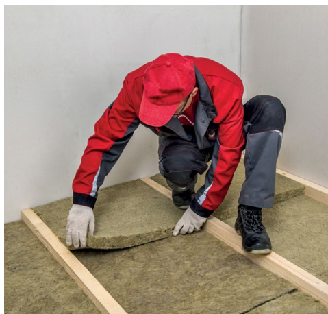
Рис. 2. Монтаж теплоизоляции враспор между лагами
