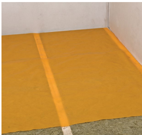
Рис. 3. Монтаж и проклейка нахлестов пароизоляционной пленки
