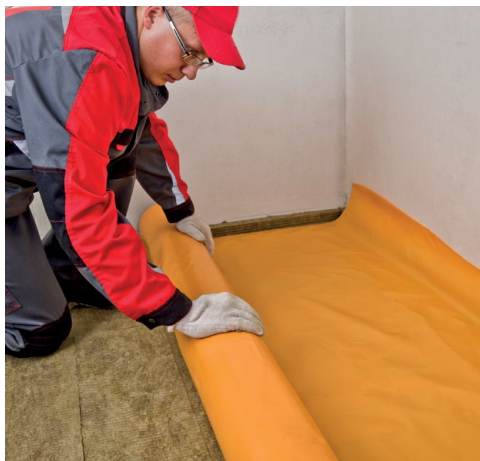
Рис. 8. Укладка гидроизоляции
