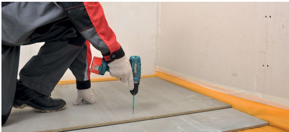
Рис. 9. Устройство сборной стяжки
