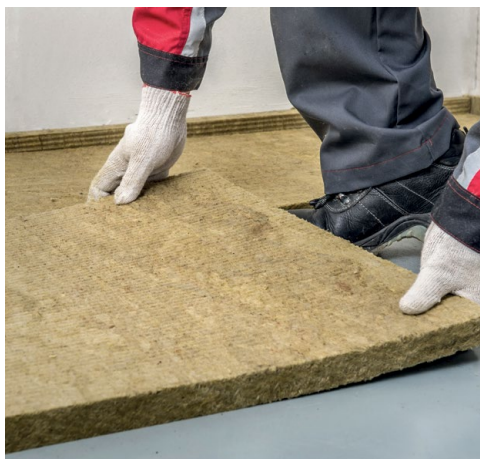
Рис. 7. Укладка плит ТЕХНОФЛОР СТАНДАРТ
