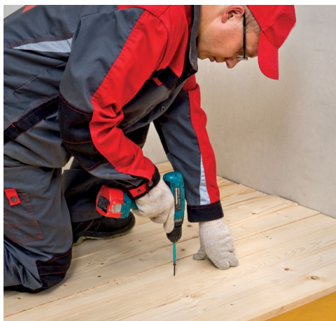
Рис. 4. Монтаж чернового пола
