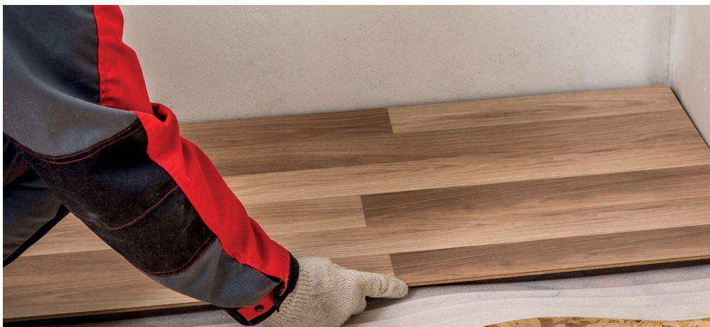
Рис. 13. Монтаж планок ламината
