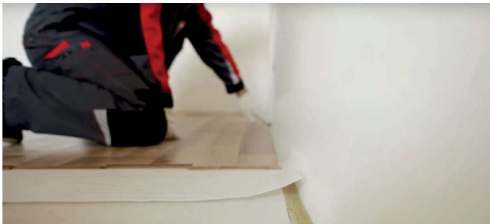
Рис. 15. Укладка ламината с зазором до стены 10 мм (в случае подрезки звукоизоляционных плит по периметру на уровне стяжки)
