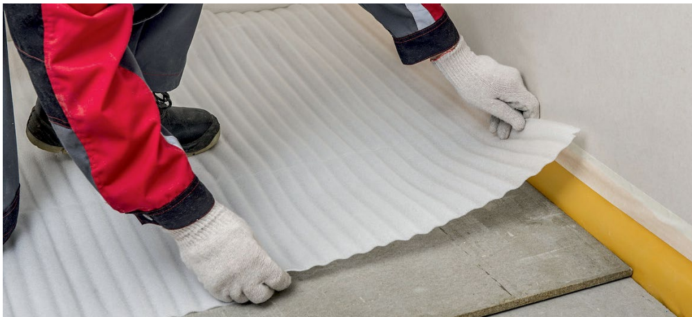
Рис. 12. Укладка подложки под финишное покрытие пола
