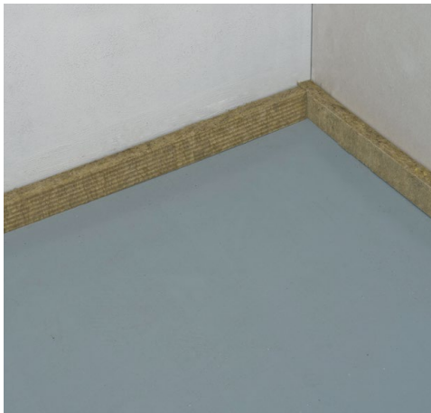
Рис. 6. Выравнивание пола, монтаж полос из каменной ваты по периметру
