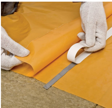
Рис. 3. Монтаж и проклейка нахлестов пароизоляционной пленки
