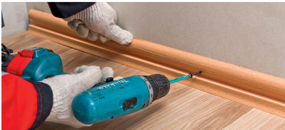
Рис. 16. Крепление плинтуса
