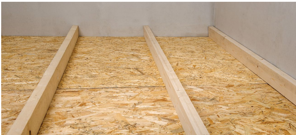
Рис. 1. Подшивка лаг снизу
