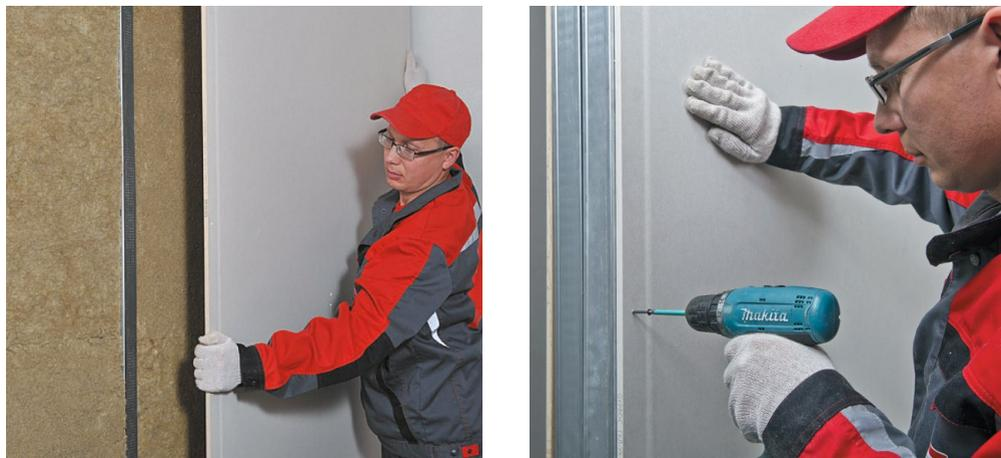
Рис. 13. Обшивка стен листами ГКЛ
