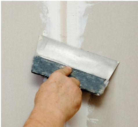
Рис. 8. Заделка швов
