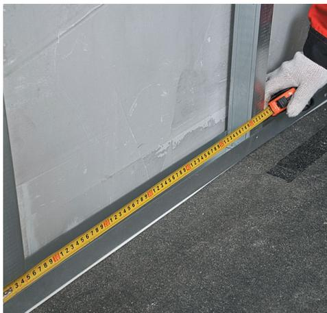
Рис. 11. Установка направляющего и стоечного профилей
