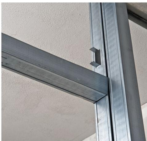
Рис. 4. Установка стойечного профиля
