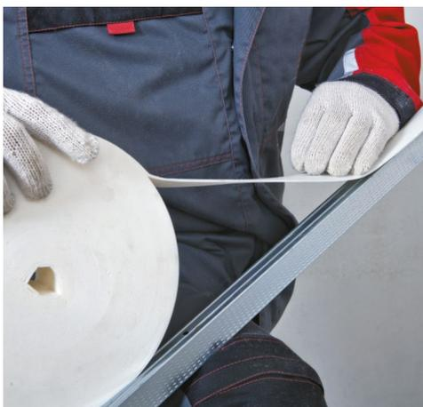
Рис. 10. Приклейка уплотнительной ленты к профилям и резка профиля
