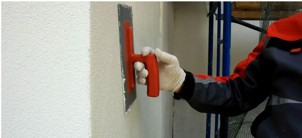
Рис. 15. Нанесение декоративного слоя штукатурки
