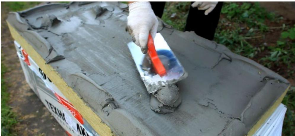
Рис. 5. Нанесение клея на плиту контурно-маячковым методом приклейки
