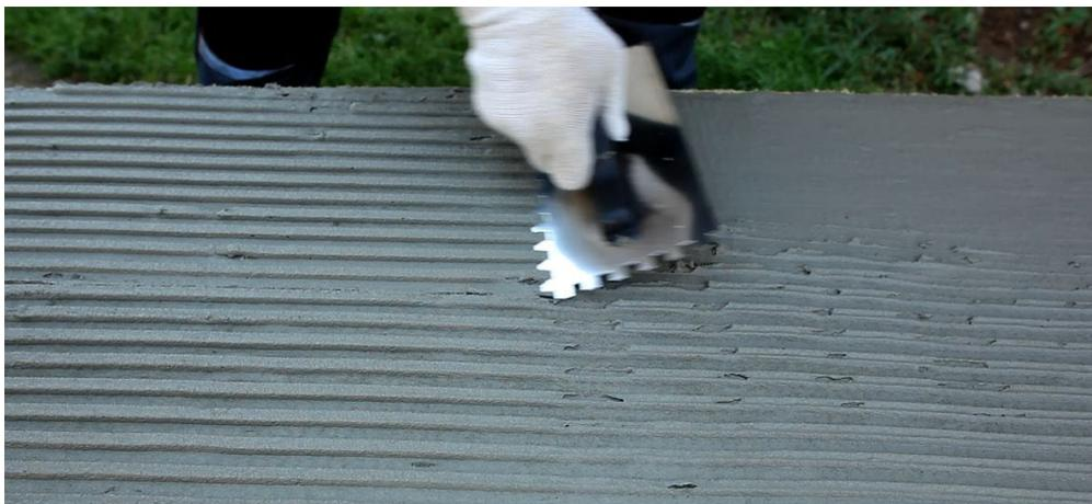
Рис.4. Нанесение клеевого состава на плиту сплошным методом приклейки
