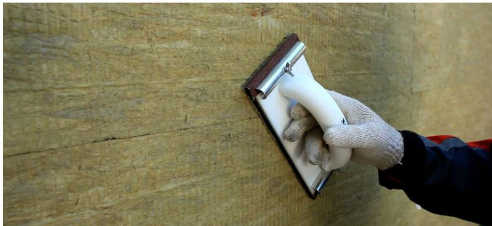
Рис. 9. Шлифовка стыков плит теплоизоляции наждачной бумагой
