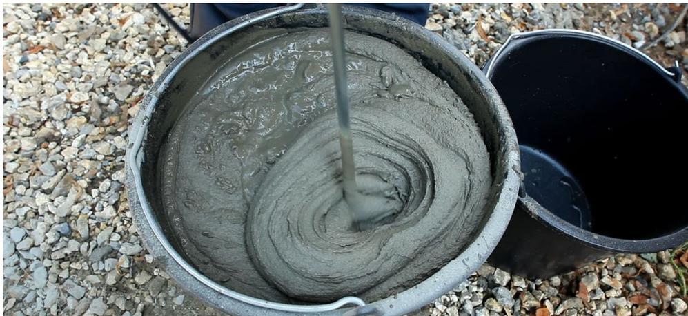
Рис. 3. Замешивание клея для приклейки теплоизоляции
