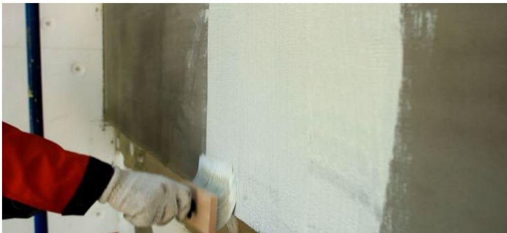
Рис. 14. Нанесение кварцевой грунтовки на поверхность базового штукатурного слоя
