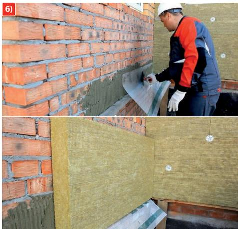
Рис. 2. Установка опорного профиля для первого ряда теплоизоляции
