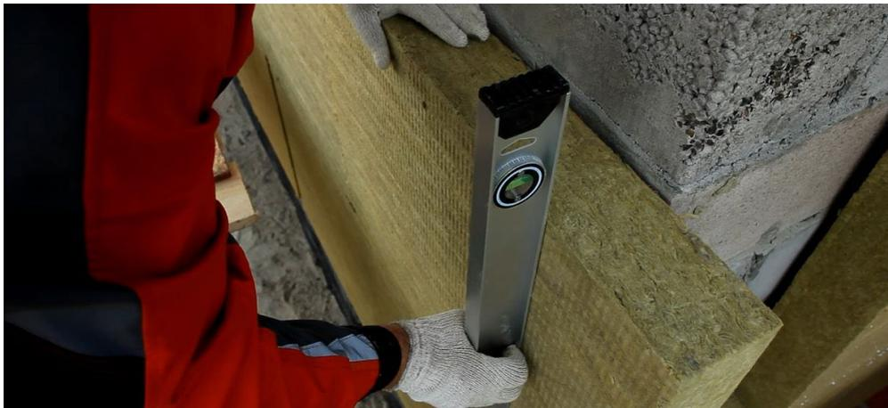
Рис. 6. Приклейка плиты теплоизоляции к стене
