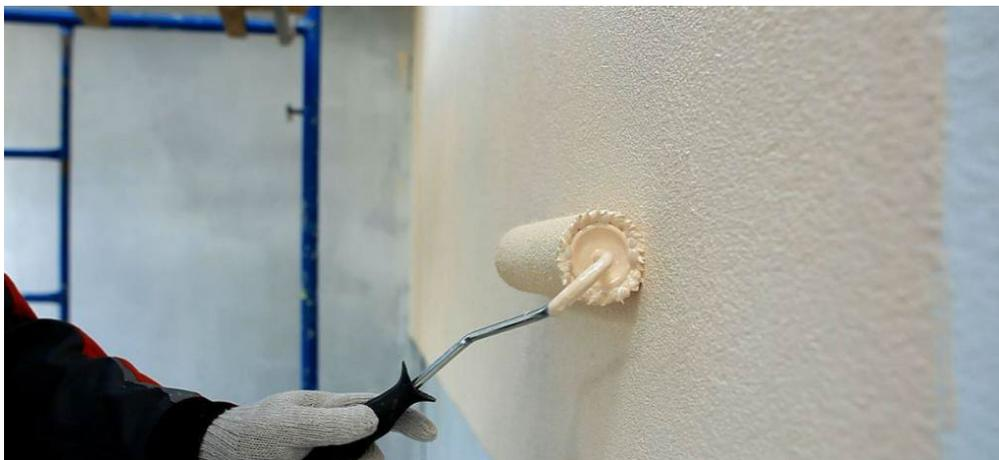
Рис. 16. Нанесение краски на поверхность фасада
