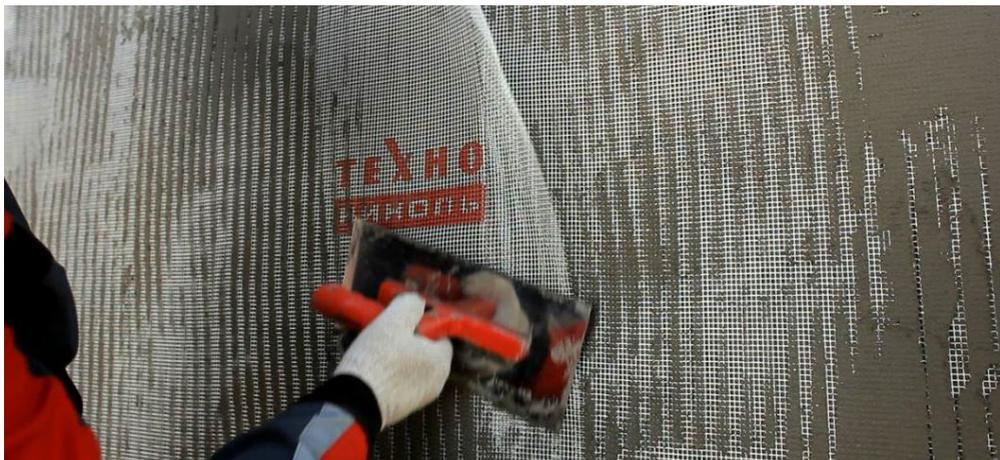
Рис. 13. Монтаж базового штукатурного слоя, армированного стеклосеткой
