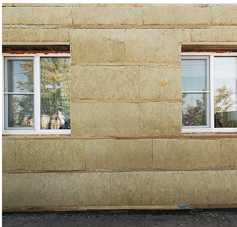
Рис. 4. Монтаж теплоизоляционных плит в горизонтальный каркас
