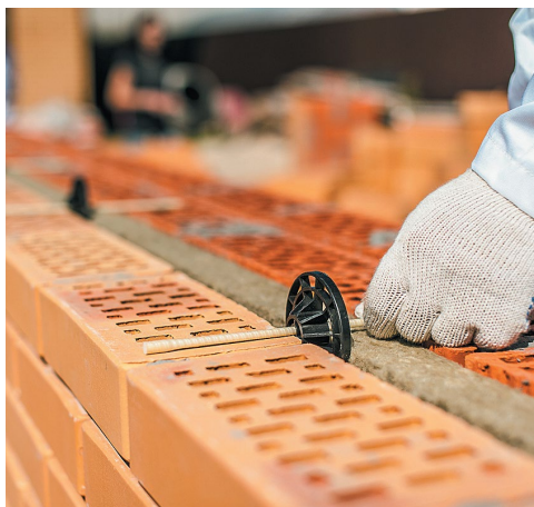
Рис. 13. Установка гибких связей
