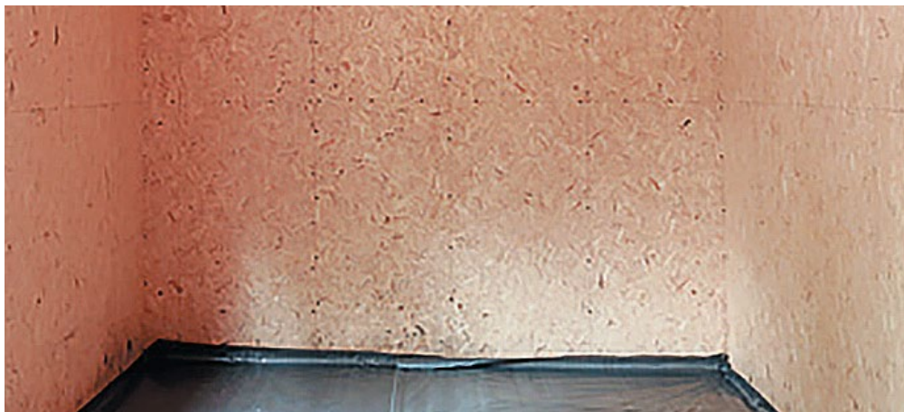
Рис. 23. Обшивка внутренней поверхности стен
