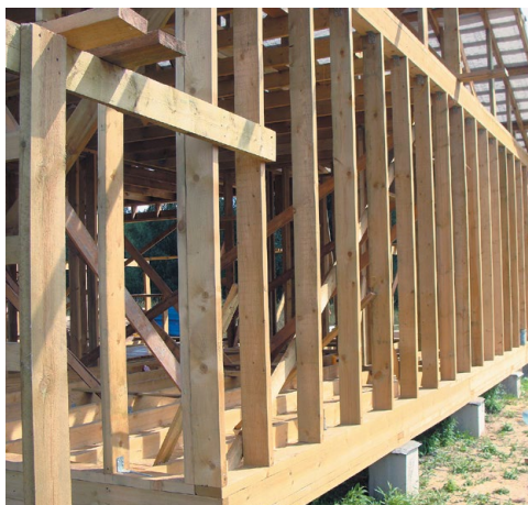
Рис. 18. Установка деревянного каркаса
