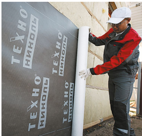
Рис. 5. Монтаж и проклейка стыков полотен ветро-, влагозащитной мембраны
