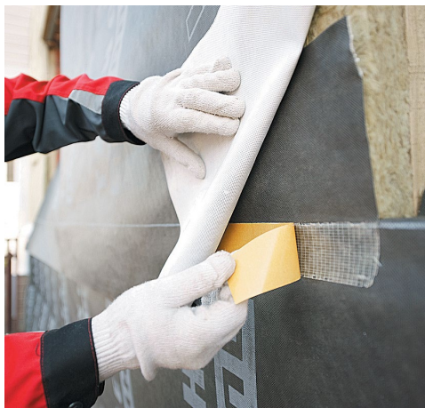
Рис. 5. Монтаж и проклейка стыков полотен ветро-, влагозащитной мембраны
