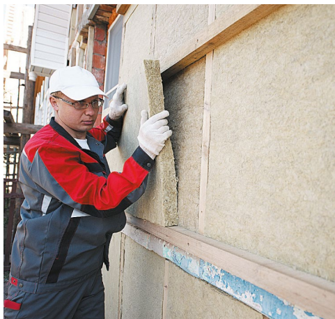
Рис. 4. Монтаж теплоизоляционных плит в горизонтальный каркас
