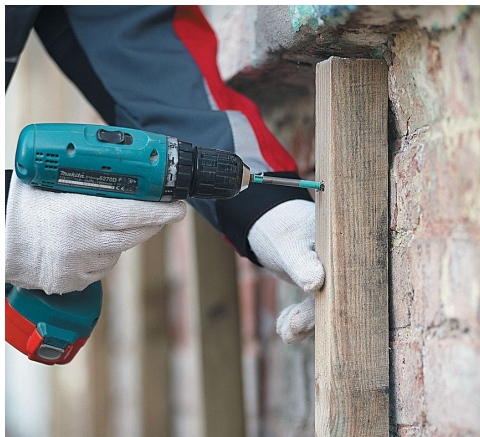
Рис. 1. Крепление вертикальных стоек деревянного каркаса
