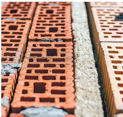
Рис. 11. Монтаж плит теплоизоляции
