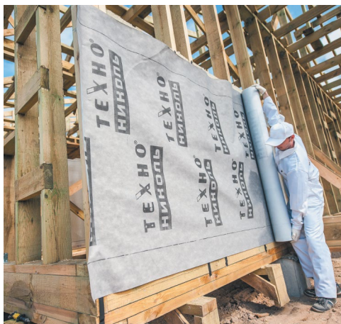
Рис. 21. Монтаж гидро-, ветрозащитной мембраны
