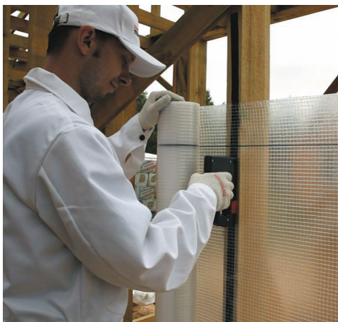
Рис. 19. Монтаж пароизоляционной пленки
