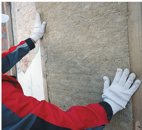
Рис. 2. Монтаж теплоизоляционных плит в вертикальный каркас
