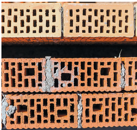
Рис. 10. Монтаж внутренней версты
