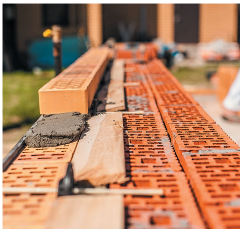
Рис. 14. Монтаж внешней версты после установки гибких связей
