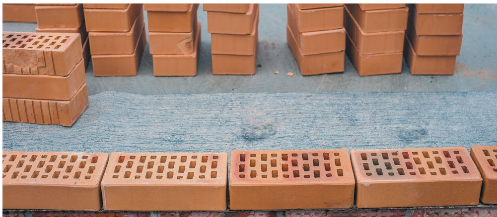
Рис. 7. Гидроизоляционная отсечка
