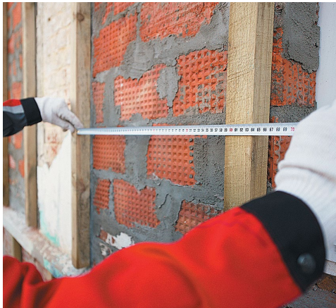
Рис. 1. Крепление вертикальных стоек деревянного каркаса
