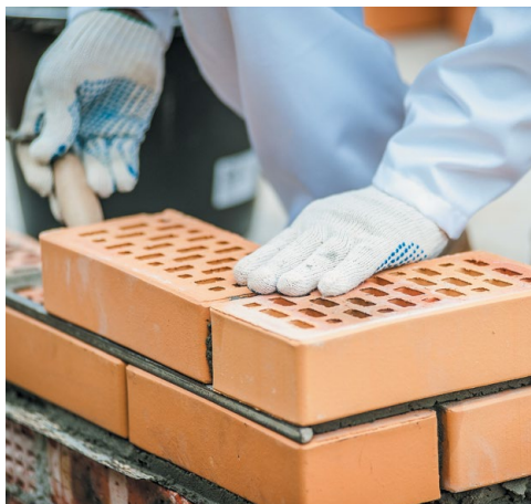
Рис. 9. Монтаж внешней версты
