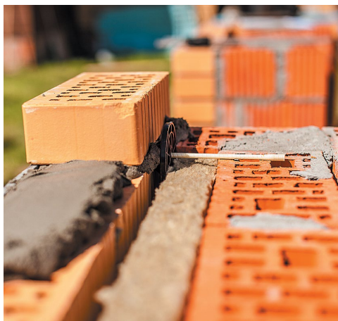
Рис. 14. Монтаж внешней версты после установки гибких связей
