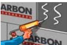
Прикрепите плиты XPS ТЕХНОНИКОЛЬ CARBON ECO на стены при помощи клеевых составов, не содержащих растворителей (жидкие гвозди для пенополистирола, полимерно-цементные смеси). Клей следует наносить точечно, либо волнообразно. Дополнительно закрепите плиты при помощи пластиковых фасадных дюбелей из расхода 4 шт на 1 м<sup>2</sup>.
