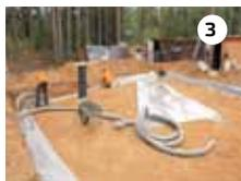
3 Монтаж закладных, подвод воды, обустройство дренажной и канализационной системы
