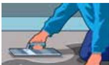
Поверхность пола очищается от старого покрытия и выравнивается специальными растворами или цементно-песчаной смесью.
