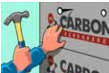
При использовании XPS с гладкой поверхностью, следует выполнить фрезеровку при помощи щётки с металлическим ворсом или ножовку по дереву с мелкими зубьями для улучшения сцепления со штукатурными составами.
