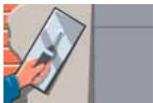
На выровненную поверхность цоколя укладываются плиты XPS ТЕХНОНИКОЛЬ CARBON ECO FAS, которые имеют специальную фрезерованную поверхность для улучшенной адгезии клеящих составов.
