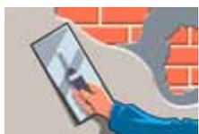
Перед утеплением стены необходимо подготовить. Удалить осыпающуюся штукатурку, срезать выступающие части (гвозди, арматура) и выровнять поверхность штукатурными составами.
