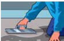
Поверхность пола очищается от старого покрытия и выравнивается специальными растворами или цементно-песчаной смесью.
