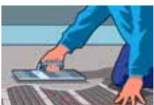
Затем производится заливка цементно-песчаной стяжки, и укладка финишного покрытия.
