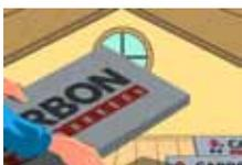
После подготовительных работ производится укладка плит XPS ТЕХНОНИКОЛЬ CARBON ECO со смещением торцевых стыков в соседних рядах. Поскольку плиты имеют L-образную кромку – основание из теплоизоляции получается монолитным, без мостиков холода, кроме того сборка таких плит не составит труда.
