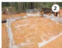
2 Укладка геотекстильного полотна; послойная укладка выравнивающего слоя песка с трамбованием и смачиванием каждого слоя
