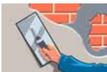
Подготовьте поверхность стен, удалив старую осыпавшуюся штукатурку, выступающие части конструкций (гвозди, арматура), и выровняйте поверхность штукатурными составами.
