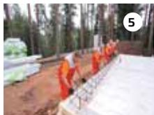
5 Армирование ребер жесткости и основной части фундамента
