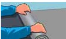
Производится укладка геотекстильного полотна 300–500 г/м<sup>2</sup>, которое дополнительно снижает уровень ударного шума.
