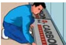
На подготовленную песчаную (гравийную) подушку укладываются плиты XPS ТЕХНОНИКОЛЬ CARBON ECO.
