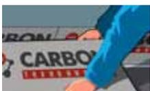
На подготовленное основание нужно уложить теплоизоляционные плиты XPS ТЕХНОНИКОЛЬ CARBON ECO со смещением торцевых стыков в соседних рядах.
