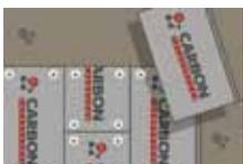
На стену при помощи клеящих смесей производят монтаж плит теплоизоляции. По необходимости, после приклеивания, плиты дополнительно крепятся пластиковыми дюбелями.
