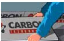
На подготовленное основание нужно уложить теплоизоляционные плиты XPS ТЕХНОНИКОЛЬ CARBON ECO со смещением торцевых стыков в соседних рядах.
