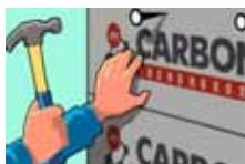
После приклеивания плит XPS ТЕХНОНИКОЛЬ CARBON ECO FAS на стену, дополнительно рекомендуется произвести механическую фиксацию плит пластиковыми дюбелями в количестве не менее 2-х штук на плиту.
